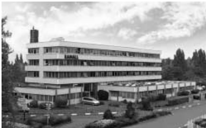
Head Office - Rosny sous Bois
